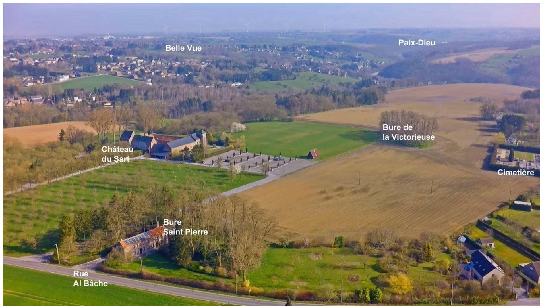
Vue aérienne avec les localisations d'endroits caractéristiques
